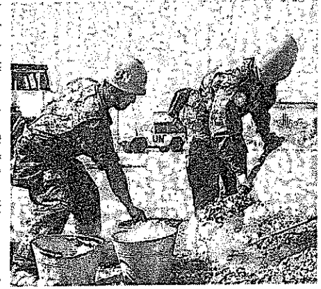
南スーダンの首都ジュバで国連施設道路の補修を行う陸上自衛隊員(防衛省ホームページから)
